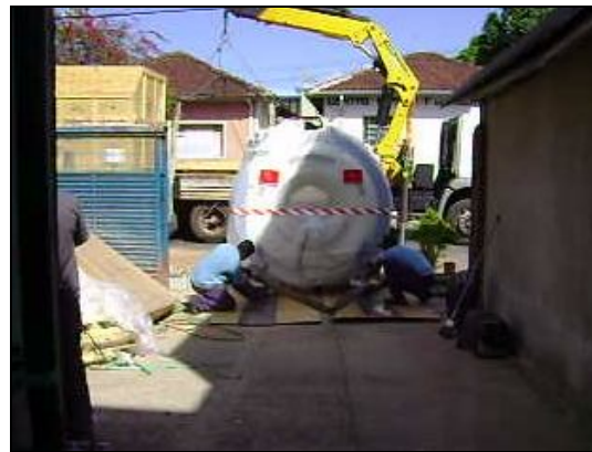
Processo de movimentação do Magneto até a sala de exames
