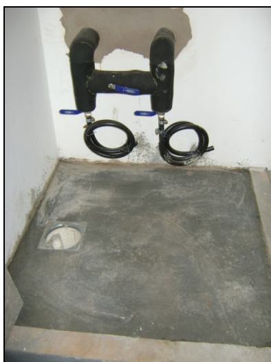
Base 0,90 x 0,90m para instalação do compressor de Hélio
