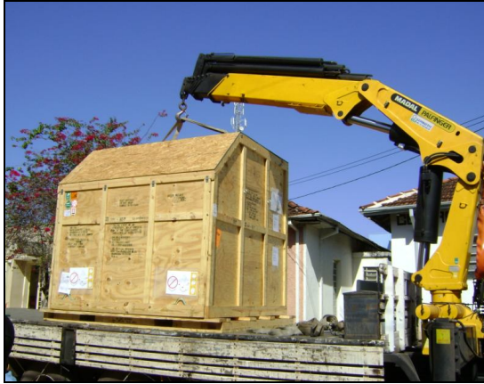
Processo de descarregamento do Magneto – utilização correta do balancim
