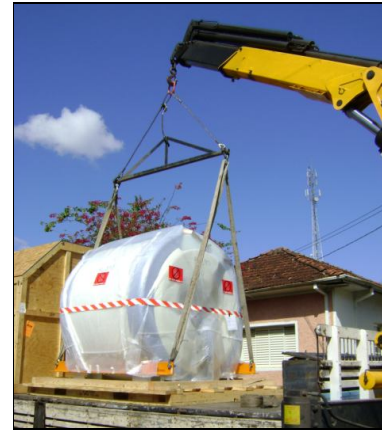
Processo de descarregamento do Magneto – utilização correta do balancim
